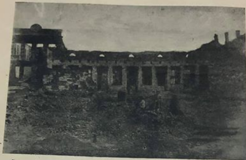
Богуслав. Разрушенное здание синагоги после погрома, проведенного повстанцами в 1919 году.
